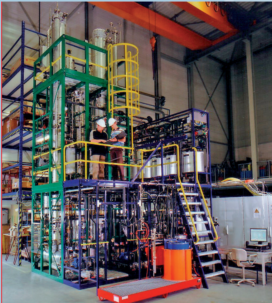
Eind-controlewerkzaamheden aan een Destillatie-eenheid
